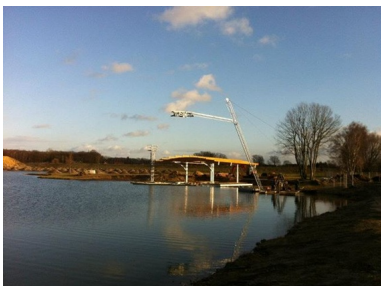
Motormast und Startbereich der neuen Bahn 2 in Hamm
