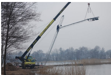
□ Kürzlich wurde der Motormast für die neue Bahn 3 des Wakepark Süsel gesetzt
